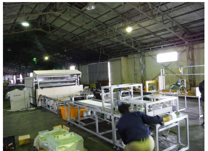
コンブ乾燥システム全景
