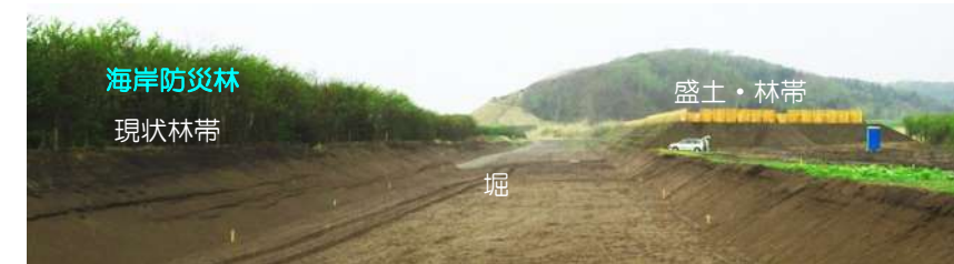
白糠町の治山事業で海岸防災林の改良工事に採用された様子
