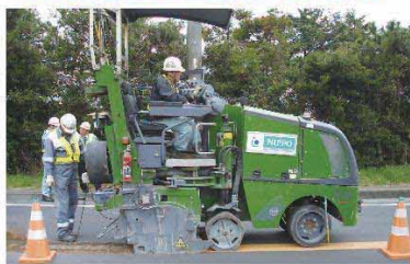
異径車輪の採用により、連続的に溝を形成
