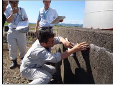
農業水利施設_揚水機場 現地研修会 (北海道土地改良区<岩見沢市> H30.7)
