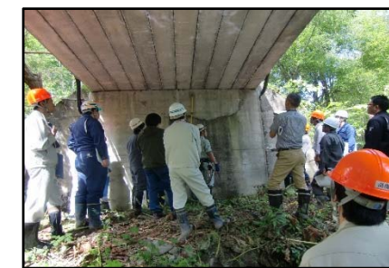
民有林林道橋梁点検技術研修会 (新十津川町 H29.8)
