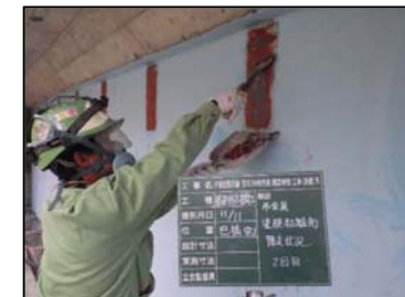
旧塗膜除去でのコスト低減・環境改善 (〇〇橋<〇〇町> H31.0)
