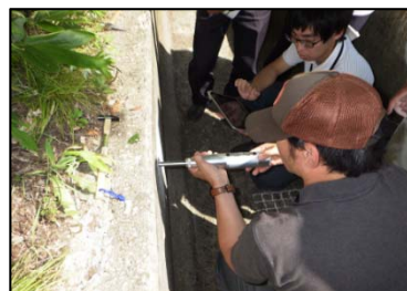
機能診断情報の収集・整理・活用 (富良野土地改良区 H30.8)
