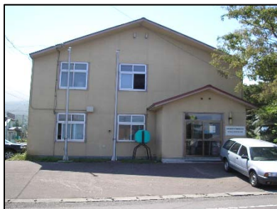
道管理施設を役場施設へ移転統合 (旧後志総合振興局社会福祉事務出張所)
