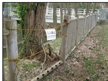
転落防護柵の立入禁止措置 (〇〇川<〇〇町> H0.0)
