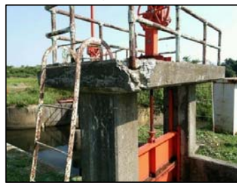
用水路の老朽化 (取水ゲート)
