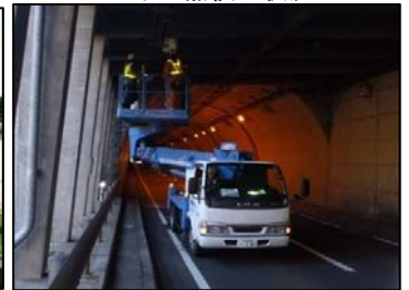
トンネル点検の状況
