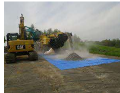
コンクリート塊破砕作業
