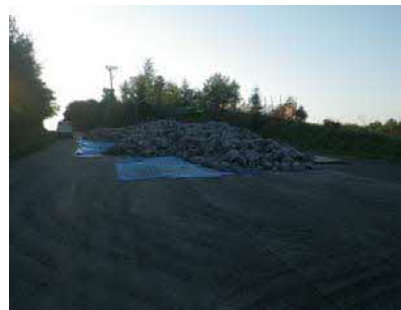
取壊したコンクリート版
