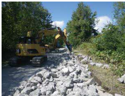
既設コンクリート版取壊し
