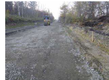
凍上抑制層転圧状況
