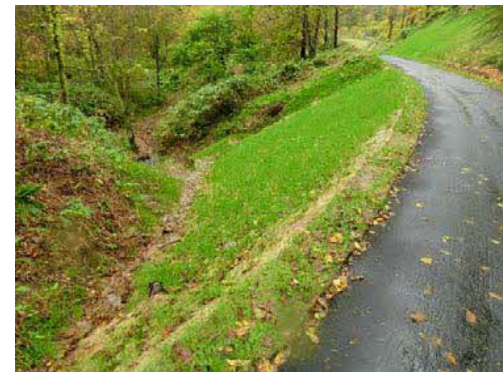
【今回】すき取り土を利用した法覆基材
