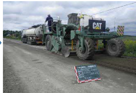
【施工】安定処理（スタビライザ）
