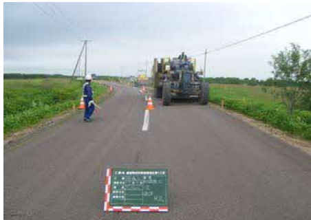
【施工】既設舗装・路盤の破碎・混合
