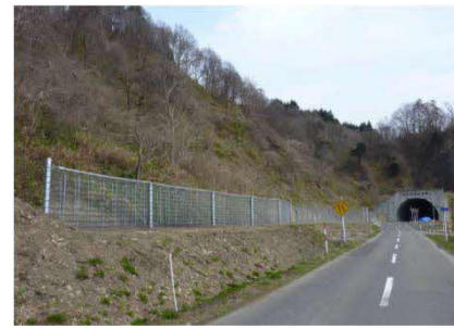
高エネルギー吸収落石防護柵
