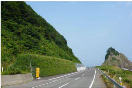
落石防護擁壁（補強土型）
