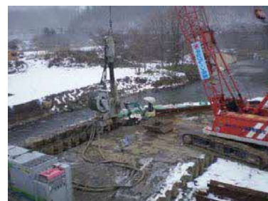
施工状況1(全景)
