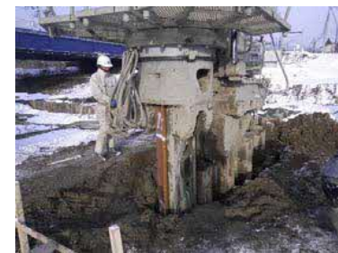
施工状況2(近景)
