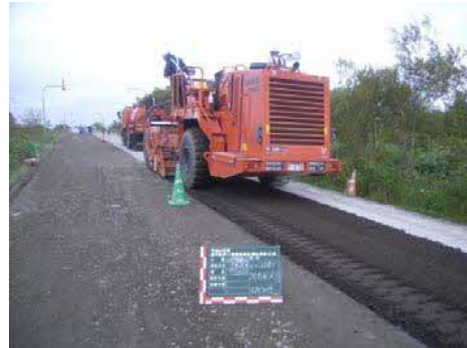
【施工】スタビライザによる混合状況
