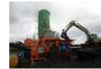
土砂とセメントの混合
