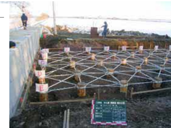
パイルネット工法施工状況
