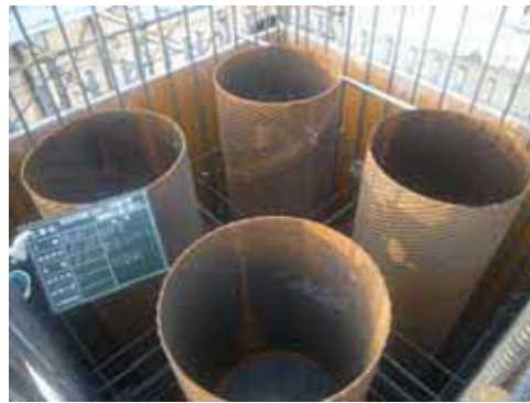
鋼管・鉄筋配置確認
