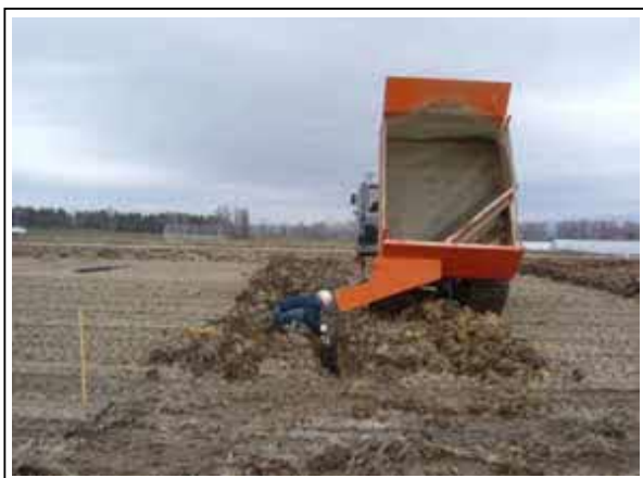
専用投入機によるビリ砂利の投入状況
