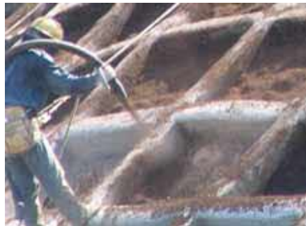
植生基材吹付状況
