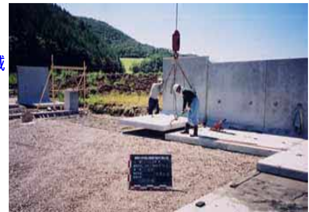
プレキャスト擁壁設置状況
