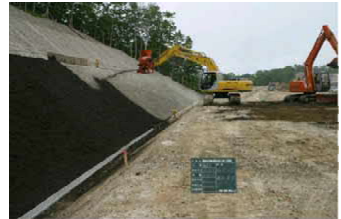
吹き付け状況写真
