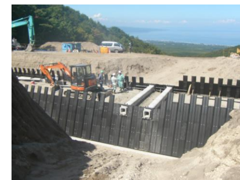
内部材設置状況
