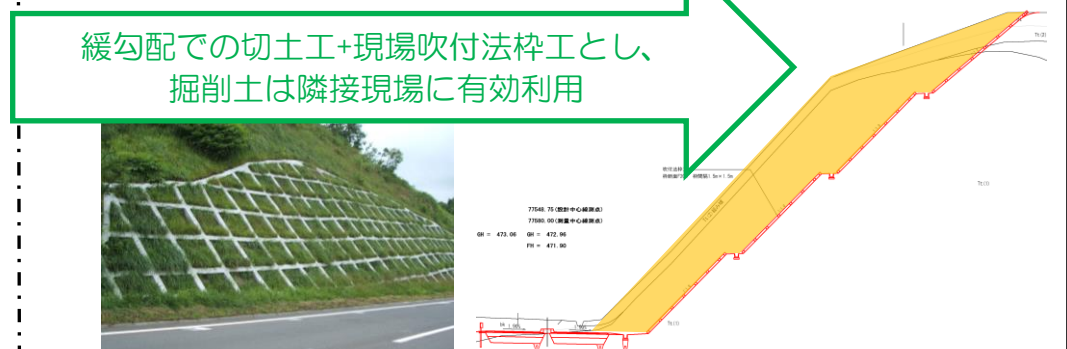
【現場吹付法砕工】
