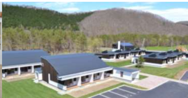
集住化住宅 「一の橋バイオビレッジ」の外観
