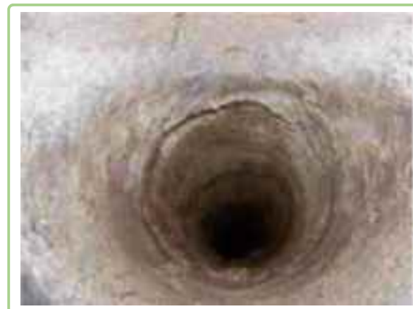
石綿含有煙突断熱材
