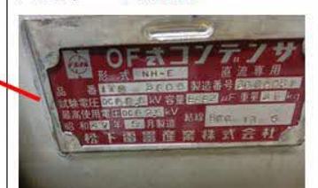
高濃度PCB「不使用」コンデンサー
