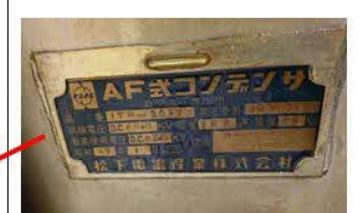
高濃度PCB「使用」コンデンサー
