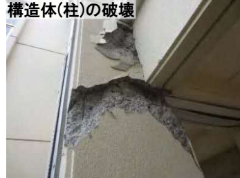
構造体(柱)の破壊
