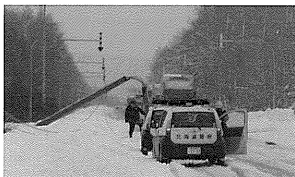
暴風雪による電柱の倒壊（国道336号 大樹町）
