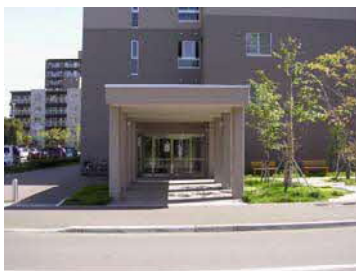
外周道路まで伸びた庇
