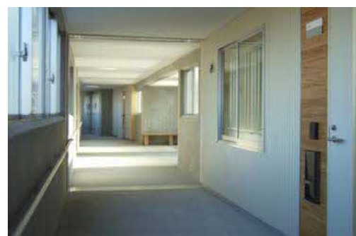
安全で快適な移動に配慮した廊下 (モルタル刷毛引きによる滑りにくい床仕上げ)
