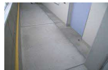
滑りにくい床仕上げ(モルタル刷毛引き)
