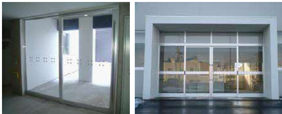
安全性や使い勝手に配慮し、十分な開口幅を確保した 道営住宅の共用玄関
