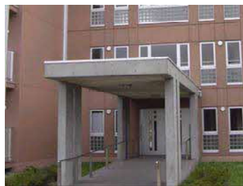
両側に手すりを設置したスロープ
