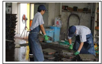
工業科：コンクリート作業
