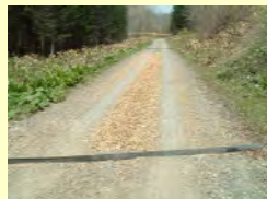
木質チップを敷き詰めた暗渠を道路の真ん中に設置し、濁りを防ぐ
