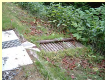
道路からの排水による削れを防ぐ木材を使った水叩き
