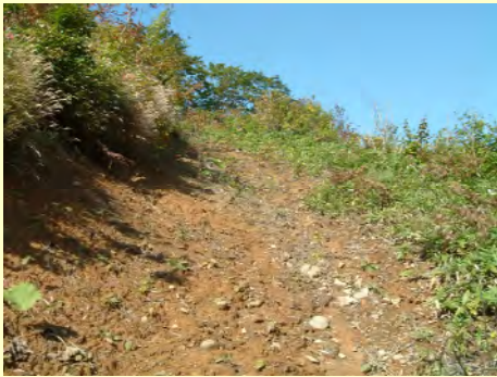
10年以上経過しても裸地のままの集材路。路面の土の硬さは、伐採した跡地や林地に比べて4～5倍硬くなっています
