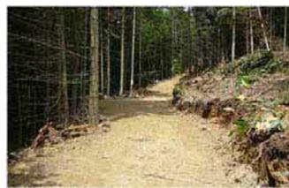
間伐をはじめとする森林整備のため継続的に用いられる道で、主として林業機械や2t積程度の小型トラック等が走行するもので、繰り返し使用に耐えるよう丈夫で簡易な構造を有する施設です。
