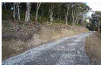
間伐材の搬出や森林管理などに10t積トラックが走行する必要最小限の規格・構造を有した林道を補完する施設です。
