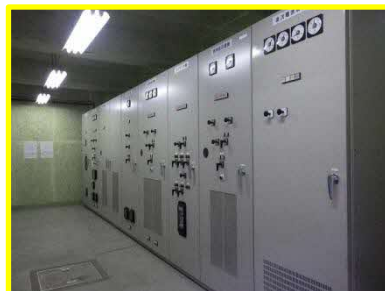
電気通信設備 「受変電設備」 (電気室内)
