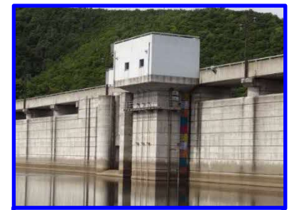
機械設備 「取水設備」 (ダム上流面)
