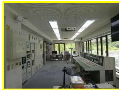
電気通信設備 「ダム管理用制御処理設備」 (ダム管理所 操作室内)
