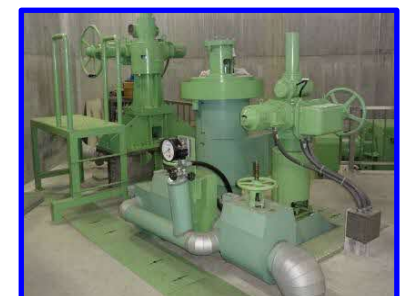
機械設備 「利水放流設備」 (利水放流設備室内)
