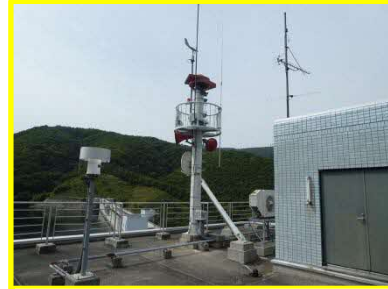
電気通信設備 「テレメータ設備」「放流警 報設備」「観測設備」 (ダム管理所屋上)
