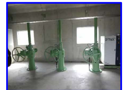
機械設備 「取水設備」 (取水ゲート室内)
