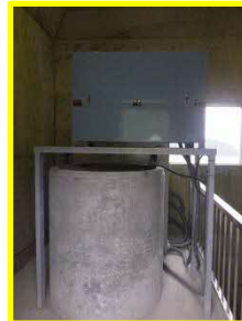
電気通信設備 「水位計設備」 (水位計室内)
