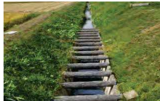
側壁を丸太で支える用水路
