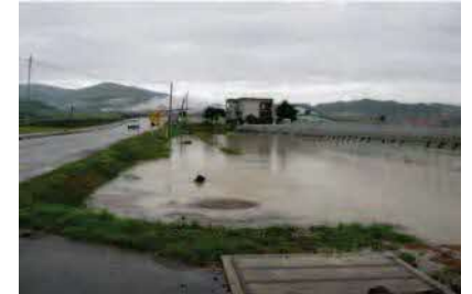
集中豪雨による冠水状況
