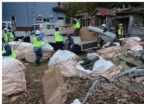
写真 3-1 2-2 : 住居の瓦礫撤去
