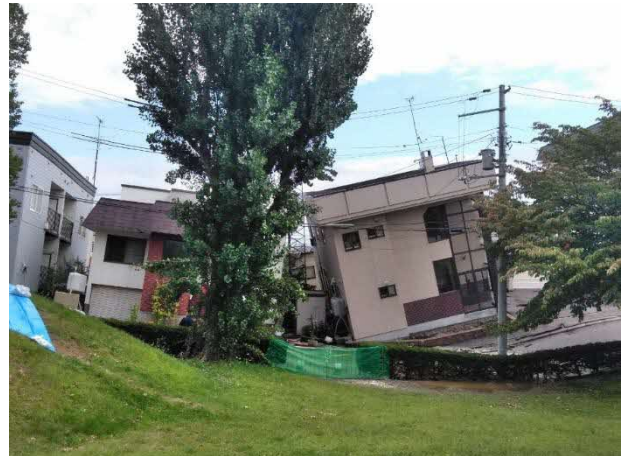
札幌市清田区（建物倒壊）
