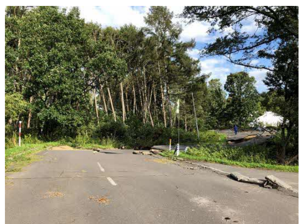
安平町 (道路損壊)
