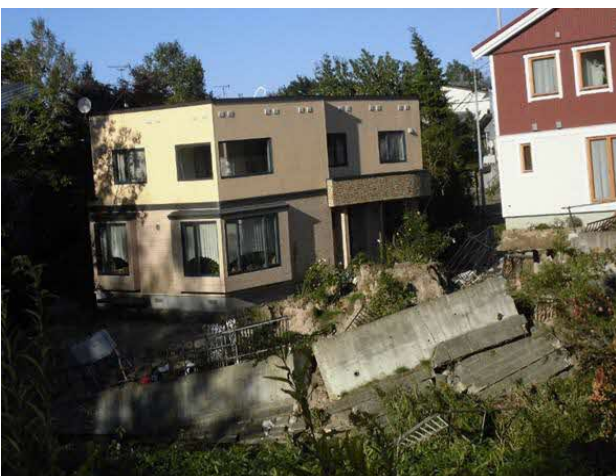
北広島市（建物倒壊）
