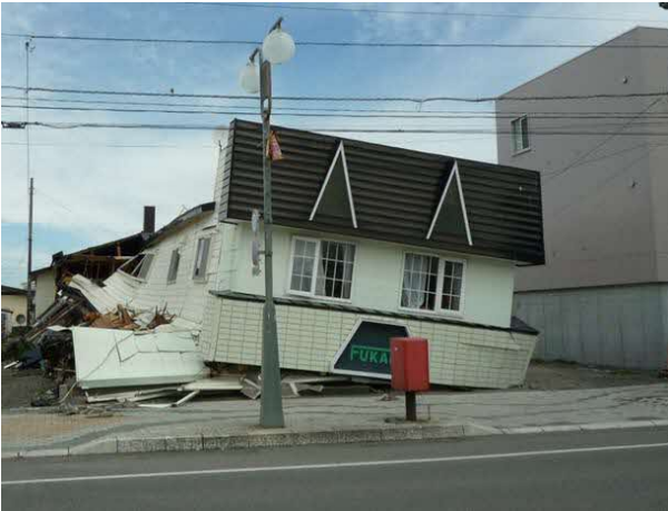
むかわ町（建物倒壊）
