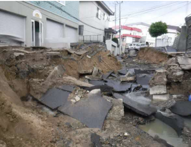
札幌市清田区（道路損壊）
