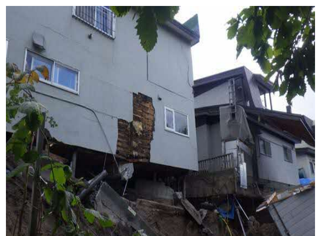
北広島市（建物倒壊）
