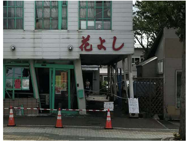
むかわ町（建物倒壊）
