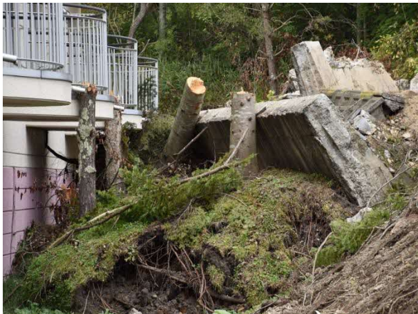
安平町 (斜面崩壊)
