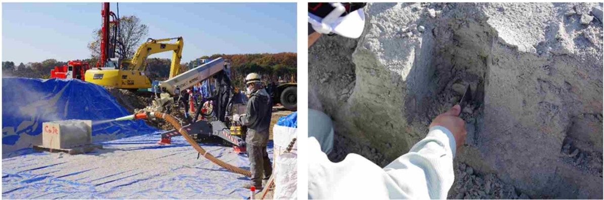
(a) ベントナイト材料の吹付け状況
