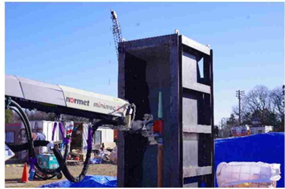
(b) 直上への吹付け
