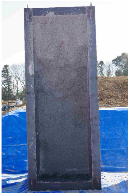
(c) V1-70の吹付け出来形
