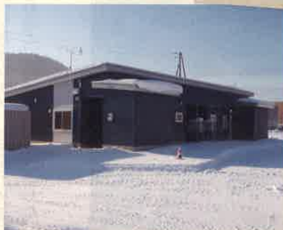
置戸町町営住宅の外観
