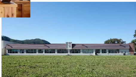
TOKOMURO Labの外観 ▶
