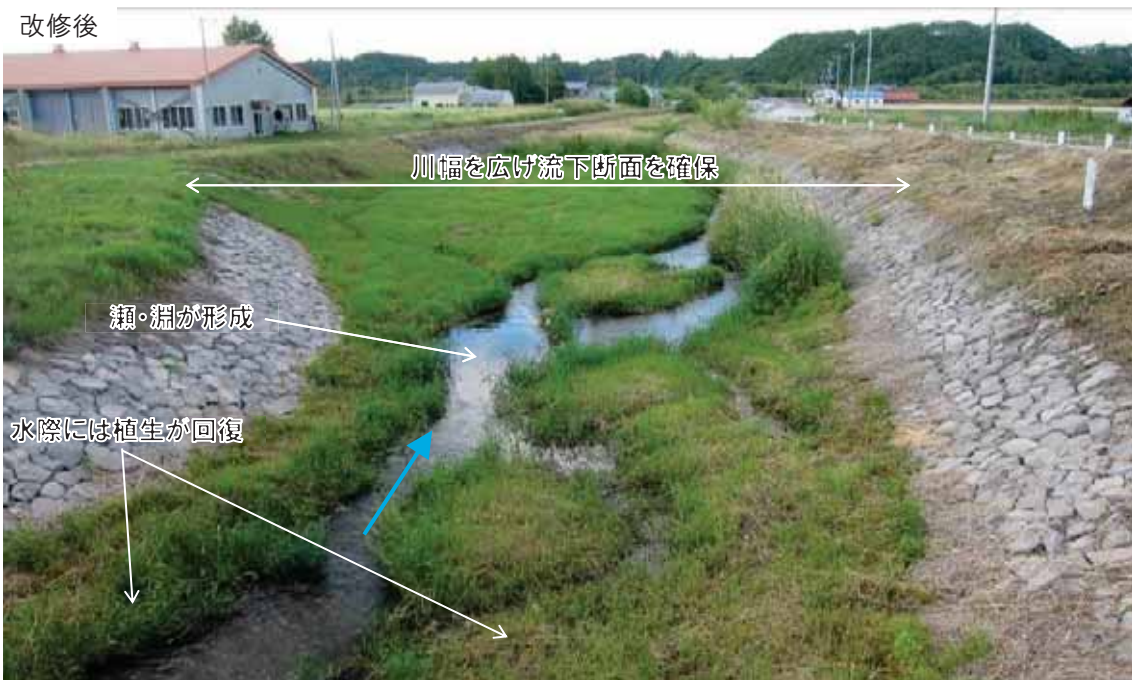
写真 3-4 こまおい 駒生川(美幌町) 改修前(上) 改修後(下) 地方部・農地の河川において、 動植物にも配慮し、川幅を広げて流下断面を広く確保した事例
