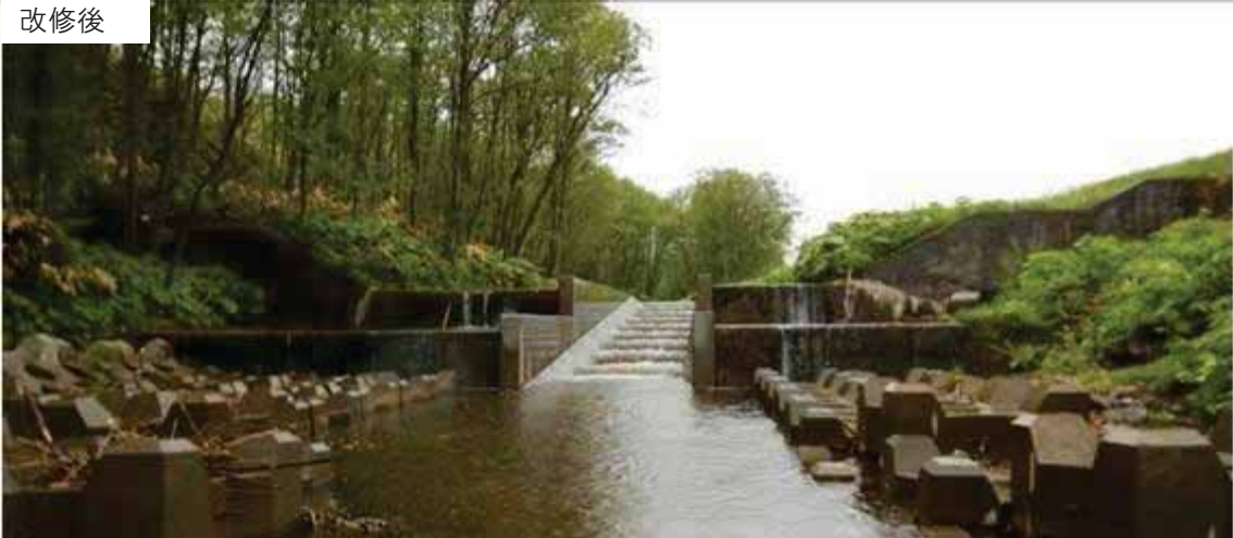
写真 3-12 ペンケオポッペ川(幌延町) 落差工の改修により連続性を確保した事例
