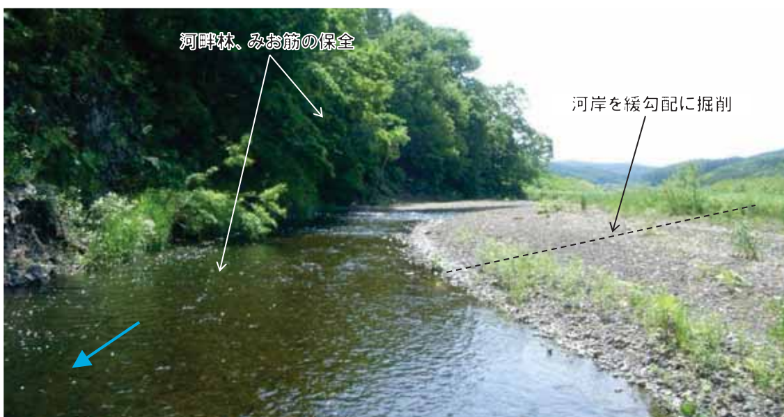
写真 3-1 隈川(北見市) 山付きの河畔林、現況のみお筋を保全し、河岸を緩勾配に掘削した事例 ※撮影年：平成 27 年 (2015)
