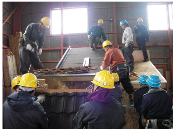
施工者を対象に施工実習を実施
