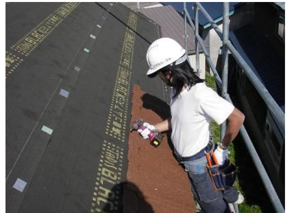
従来工法より防水力の高いシートを使用
