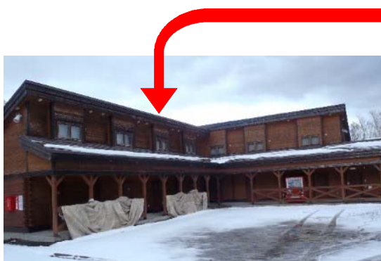
(神居尻地区 宿泊棟 全景)
