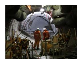
イ) 湧水発生箇所(周回坑道(東)) 手前のボーリング機2機にてグラウト注 入を行っている。
