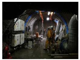
ア)メタンガス濃度上昇箇所(試験坑道 1) 調査用ボーリングを行ったところ、メタ ンガス濃度が上昇したため、作業員退避 させた。換気後、安全を確認したのちボ ーリング孔の閉口作業行う。
