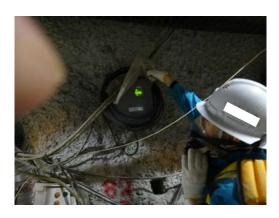
エ)メタンガス検知器(固定) 作業現場に設置
