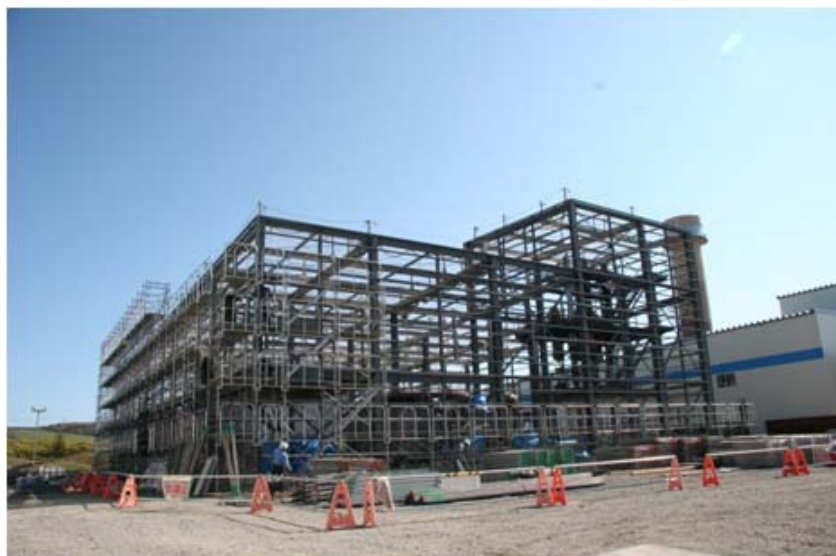
脱ホウ素設備・脱窒素設備増設工事状況
