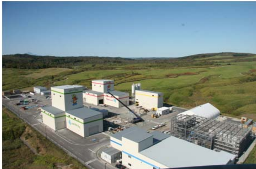
地下施設工事全景(ゆめ地創館展望台より望む)
