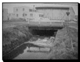
下水道整備前の河川
