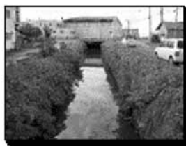
下水道整備後の河川
