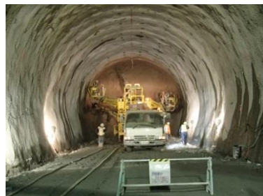
北海道新幹線 (二ツ森トンネル現場)
