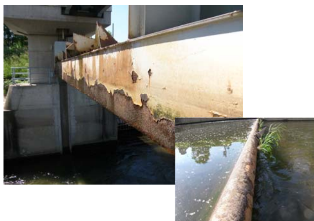
(堰) 洪水吐、土砂吐ゲートの腐食
