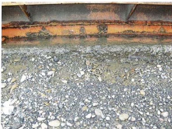
(堰) 転倒ゲート下部戸当りの腐食
