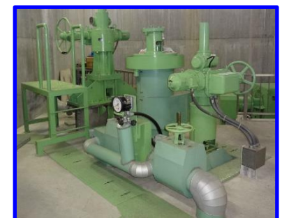
機械設備 「利水放流設備」 (利水放流設備室内)
