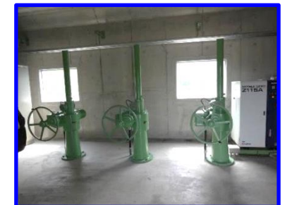
機械設備 「取水設備」 (取水ゲート室内)
