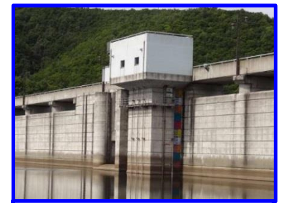
機械設備 「取水設備」 (ダム上流面)
