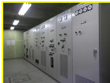
電気通信設備 「受変電設備」 (電気室内)
