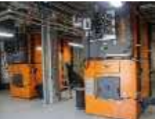
(木質バイオマスボイラ)
