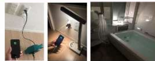
(写真左) 右コンセントがPV自立用 (写真中) 左コンセントがエネファーム自立用 (写真右) 停電時に家庭用コジェネでお風呂を沸かしている様子
