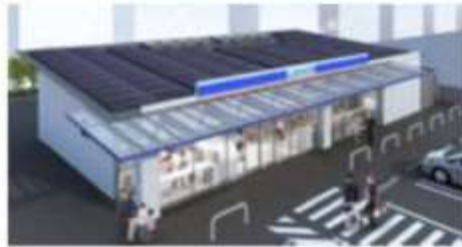
■ローソン小平天神町二丁目店 主な創エネ・省エネ設備
