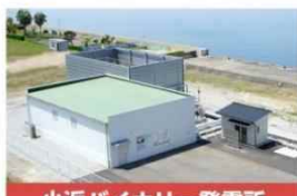
小浜バイナリー発電所
