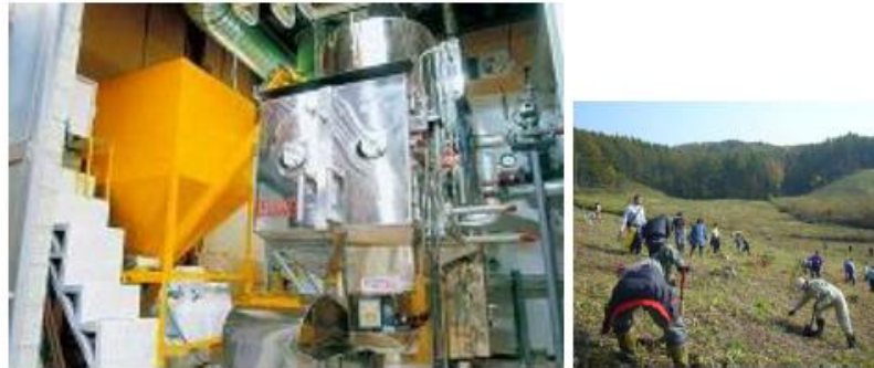
社内循環型バイオマスボイラーの外観
