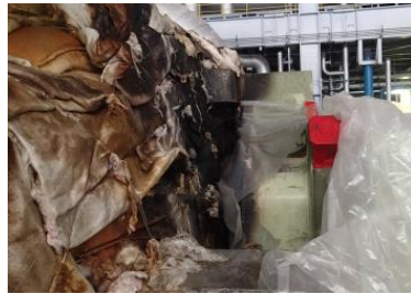
ケーシング内部の状況
