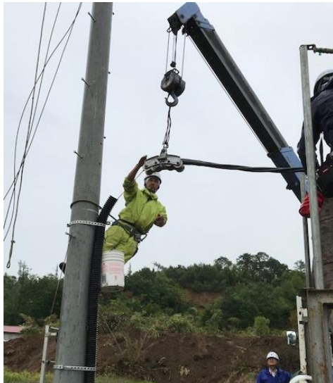
高压ケーブルによる応急送電
