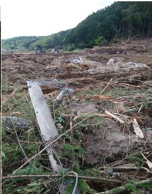
土砂崩れによる電柱流失
