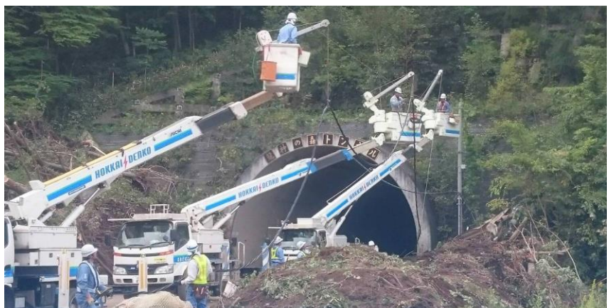
道路啓開箇所での復旧作業(厚真町幌内)
