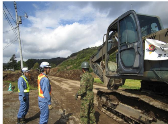
自衛隊と協力し復旧作業を実施(厚真町幌里)
