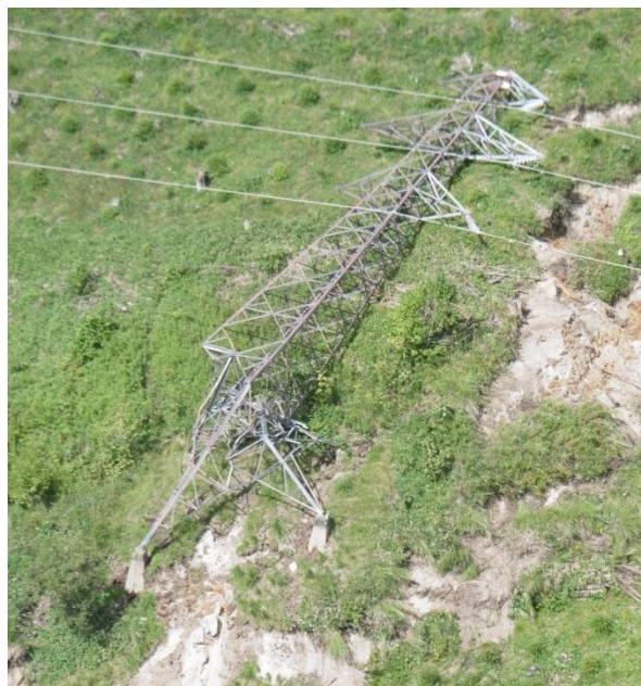
鉄塔倒壊箇所(岩知志線)
