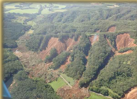
<被害状況調査>
