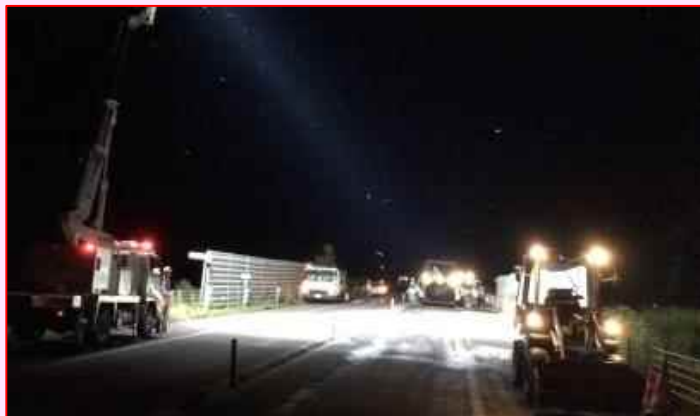
照明車による夜間作業支援
