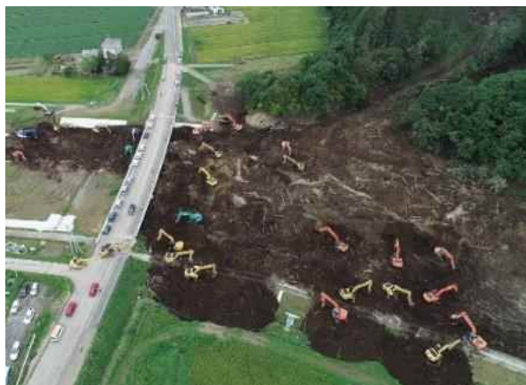
土砂撤去作業 (厚真町)
