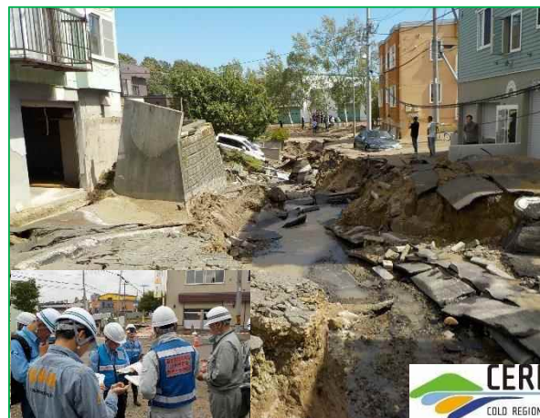
液状化被害に関する専門家チームの派遣 (札幌市)
