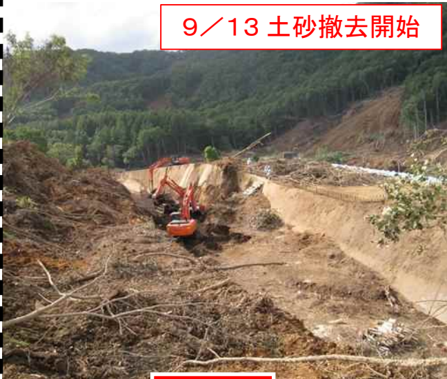
土砂撤去状況
