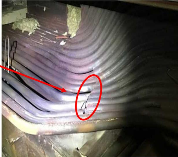
2号機 ボイラ配管損傷箇所
